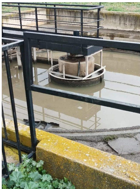
Imagen 8. Decantador secundario.
